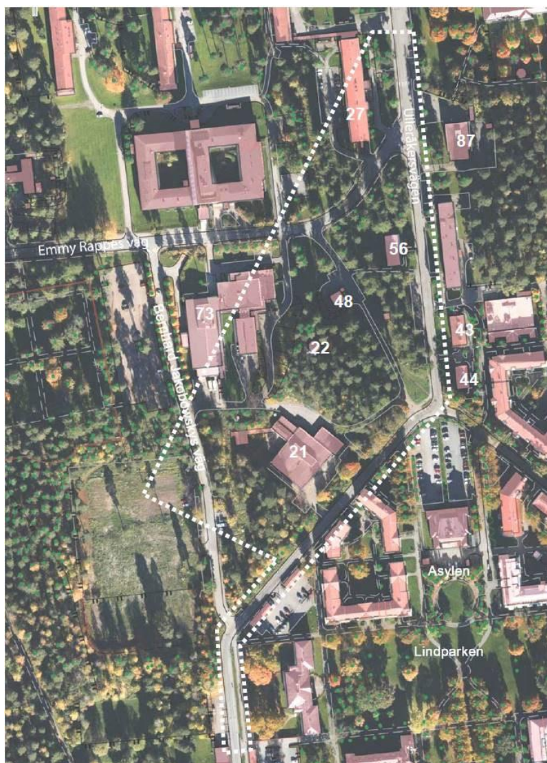
Figur 2.4.5. Flygfoto med planområdet markerat med vit streckad linje. Bebyggelsen inom området är i tur och ordning matsal (73), sjukhusbyggnad (27), vattentorn (22), portvaktstuga (48), Bostadshus sköterskor (56), Verkstad (rivet) (21) (Uppsala kommun 2016).
