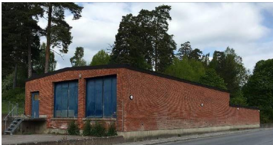
Figur 4.5.6 Sopstation invid Ulleråkersvägen (hus nr 76) innan rivning
