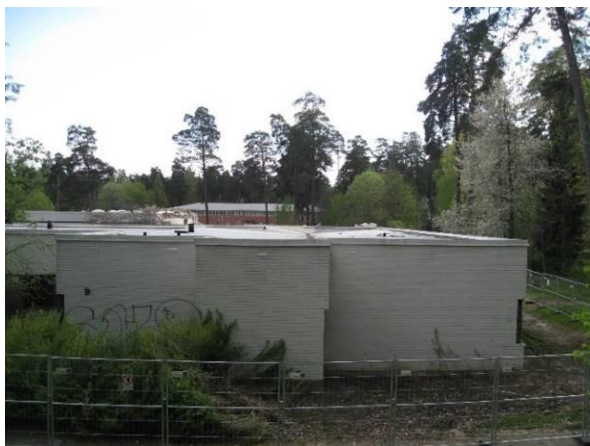
Figur 2.4.2. Byggnad 78 Neurologiskt centrum innan rivning
