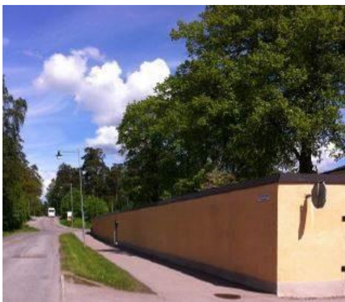
Figur 4.5.8. Ulleråkersvägen vy mot norr
