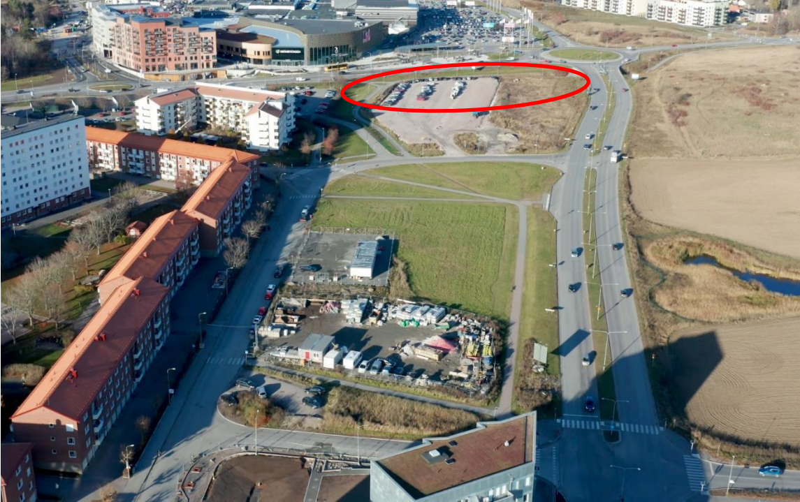
Flygfoto över området sett från söder, planområdets läge är inringat.
