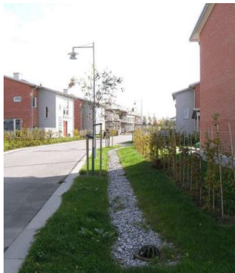
Figur 7.8 Exempel på utformning för avvattnings till makadamdike för fördröjning och infiltration.
