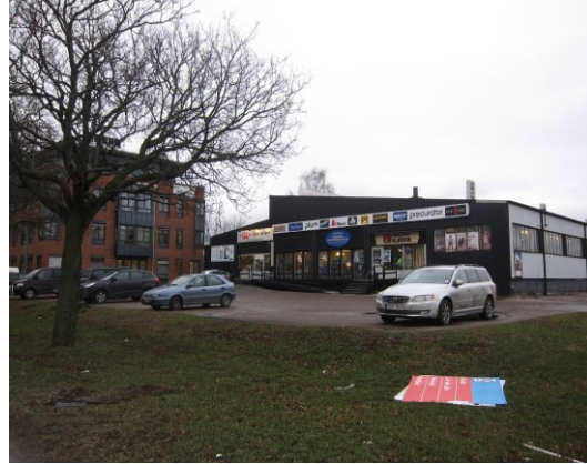
Den befintliga byggnaden sedd från Kungsgatan
