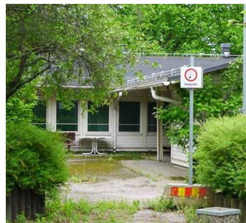
Befintlig byggnad och innergård.
