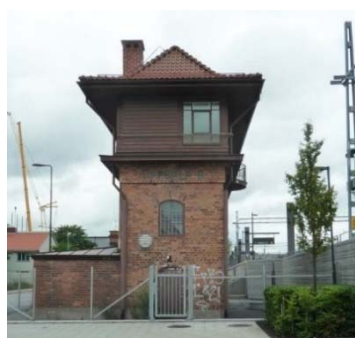
Ställverk, vy från söder.
