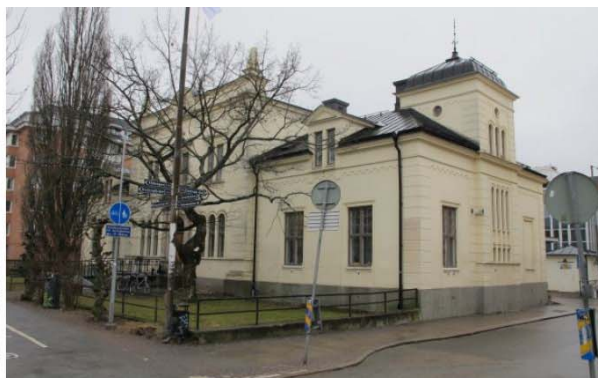
Tingshuset så som det ser ut 2016.
