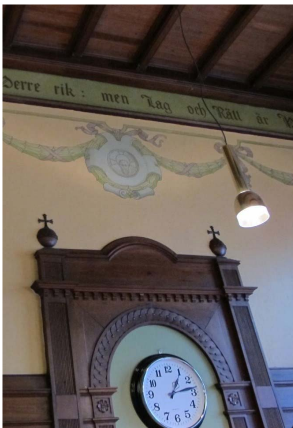
F.d. Tingssalen. Detaljbild på dekorationsmålningar och panel.
