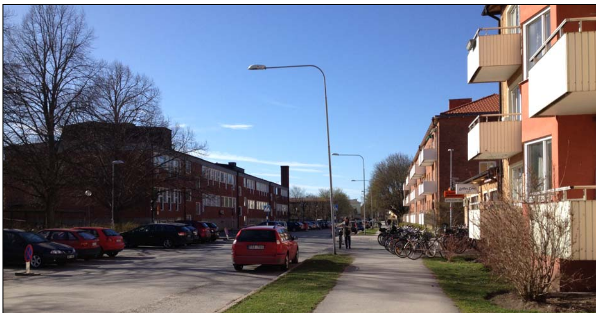
Tiundaskolan sedd från Sibyllegatan, norrut.
