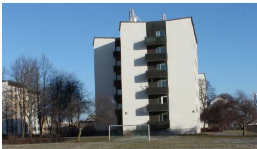
Bilden visar takvinkeln på en gavelfasad för ett av de befintliga skivhusen.
