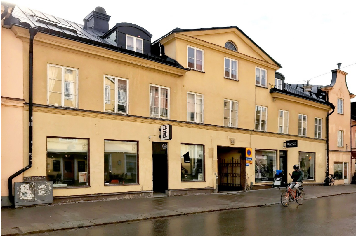
Hus A:s fasad mot Svartbäcksgatan.
