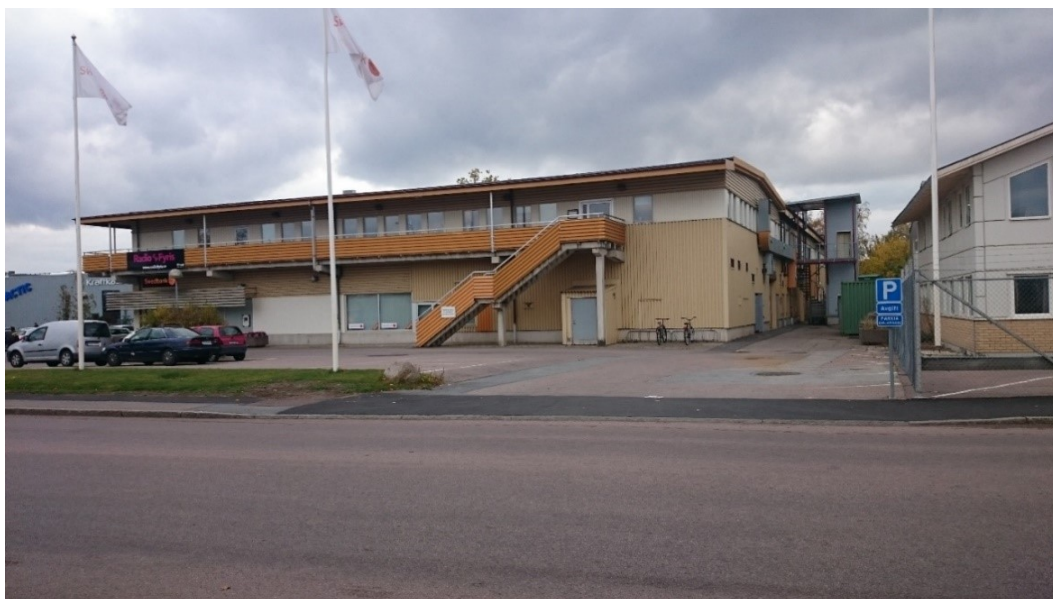
Den befintliga byggnaden sett från Björkgatan.
