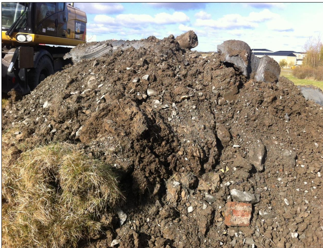
Jordmassor som grävts upp för karaktärisering och provtagning. Foto Tyréns AB 2017-05-09.
