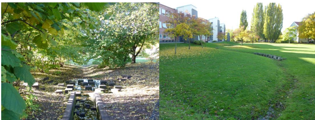
Figur 10. Exempel på utformning av en torr damm/översvämningsbar yta. Foto: WRS.
