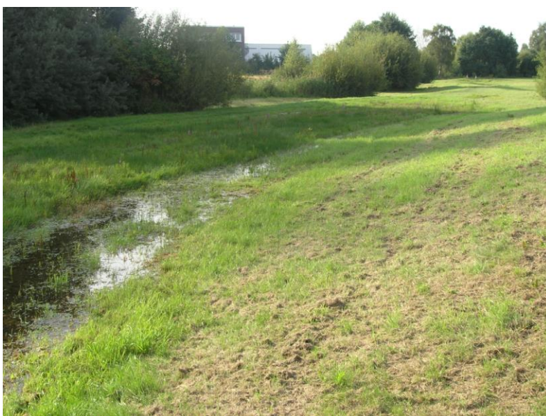
Figur 11. Exempel på en torr damm från Berlin. Ett exempel på hur en torr damm kan se ut efter ett regn. Foto: WRS.
