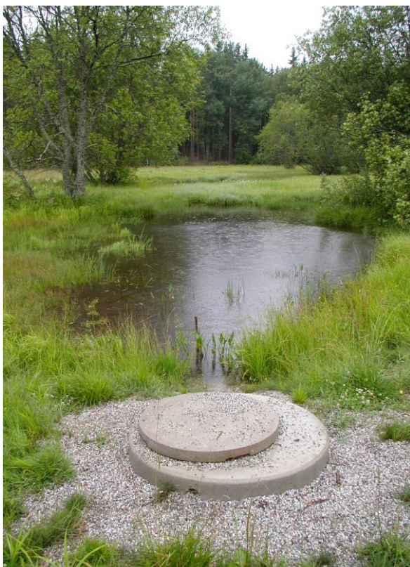
Figur 12. Exempel från Täby på en damm som fungerar som kontrollpunkt sist i dagvattensystemet. Foto: WRS.
