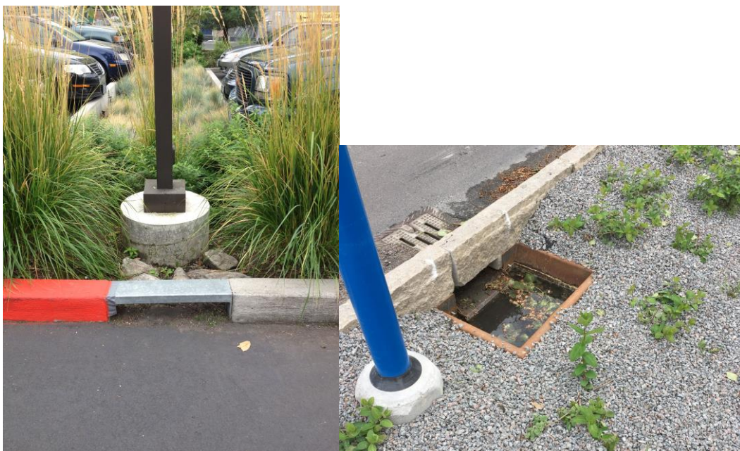
Figur 14. Två exempel på alternativ för inlopp, längs med parkering samt längs med väg. Foto: WRS
