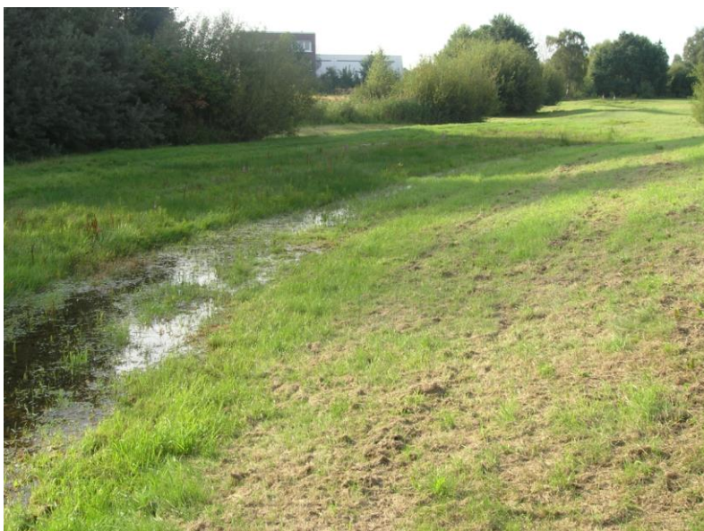
Figur 16. Exempel på en torr damm från Berlin. Ett exempel på hur en torr damm kan se ut efter ett regn. Foto: WRS.
