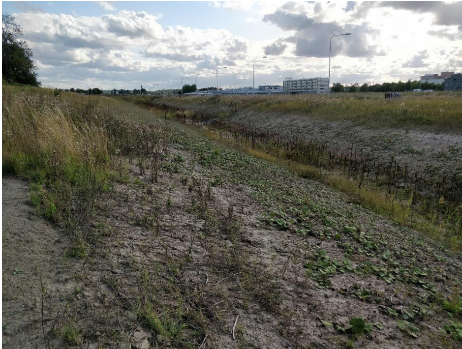
Figur 10. Exempel på hur svackdiken kan utformas. Anläggningen i bilden är större än vad som behövs för fastigheten, men principen är densamma. Foto: Sweco.
