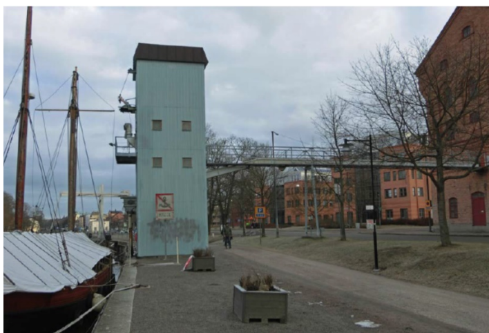
Skeppselevatorn. Foto Upplandsmuseet.
