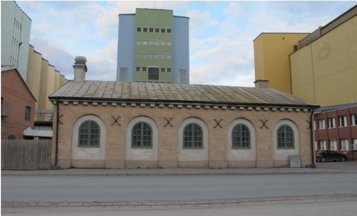
Den gamla pumpstationen från 1920-tal ritad av Gunnar Leche.
