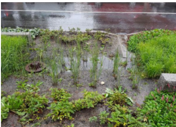
Nedsänkta växtbäddar har kapacitet att magasinera dagvatten under markytan. Foto: Bjerking.
