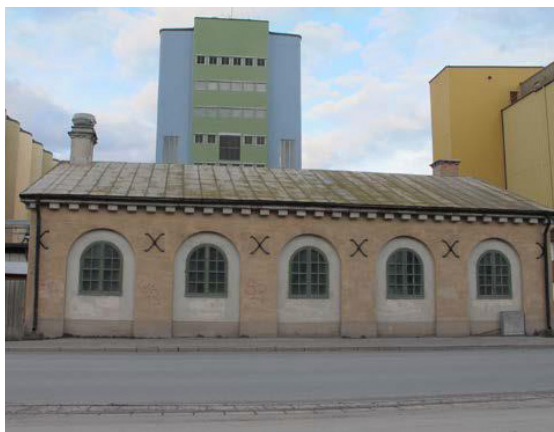
Gamla pumpstationen ritad av Gunnar Leche
