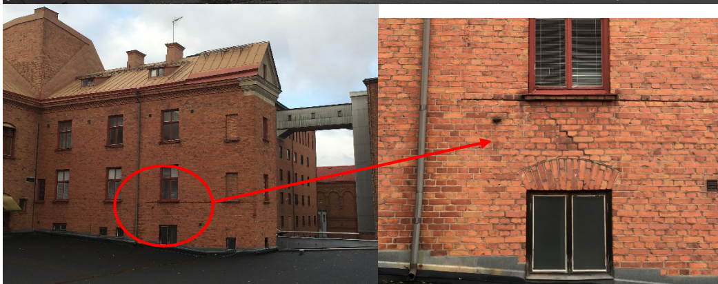
Figur 11 Sprickbildning på fasader mot innergården av Jästfabriken, Platsbesök 2016-10-28
