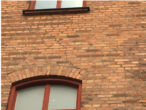
Figur 10 Sprickbildning i södra fasaden av Jästfabriken, Platsbesök 2016-10-28
