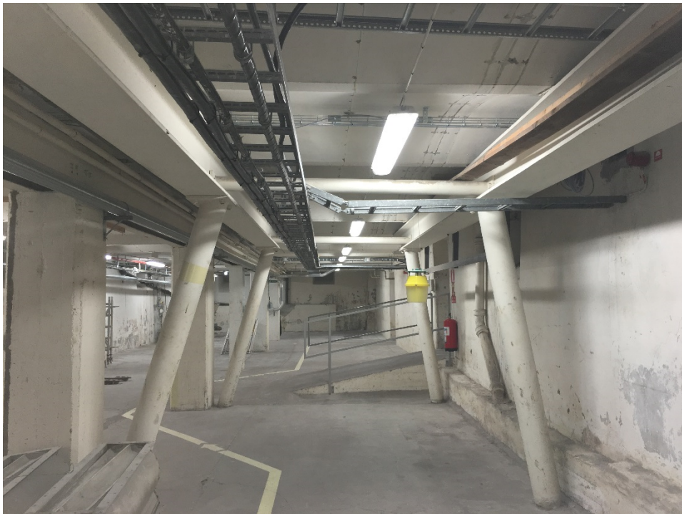
Figur 12 Sektion B-B ( figur 8 ), förstärkning av grundläggning, Jästfabriken
