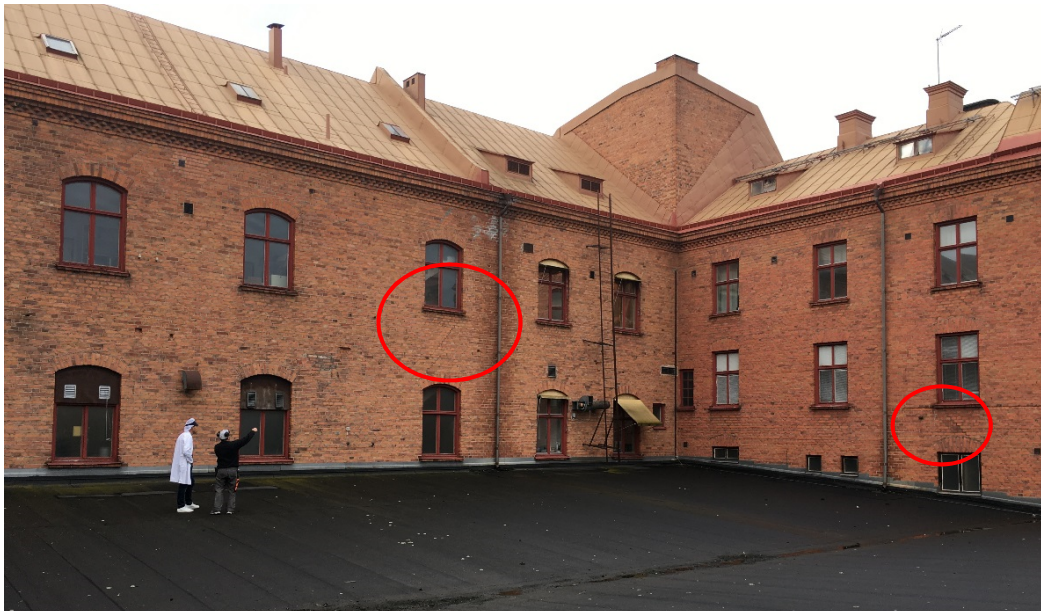
Figur 10 Sprickbildning i södra fasaden av Jästfabriken, Platsbesök 2016-10-28
