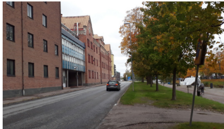
Planområdet avgränsas i väst mot Östra Ågatan och Fyrisån. (Gestaltningsprogram DP Ångkvarnen, Uppsala kommun, 2019)
