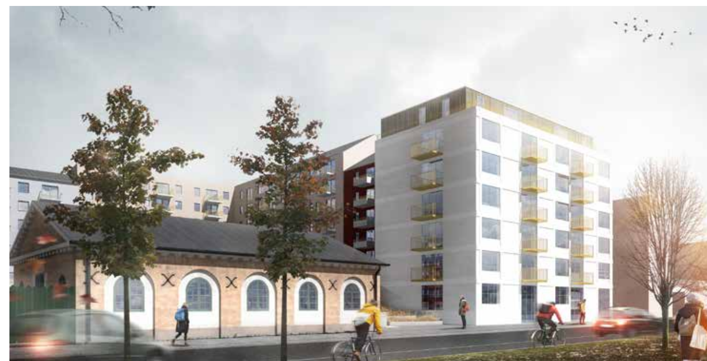
Perspektiv D: Byggnaden på Östra Ågatan
