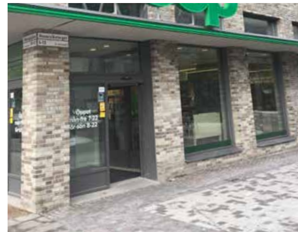
Entrée till lokal målad i stål
