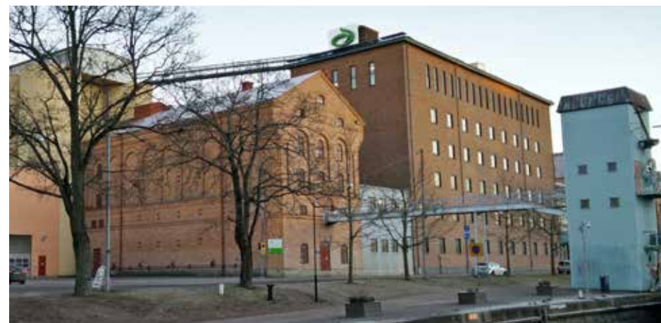
Foto: Norra entrén, Tegelsilon
