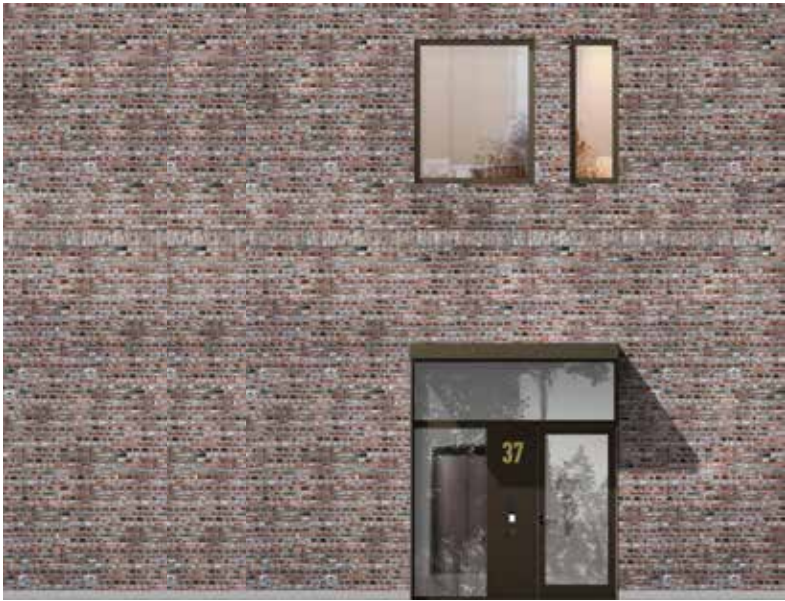
Två rader utskjutande tegelsten markerar sockelvåningen (A)
