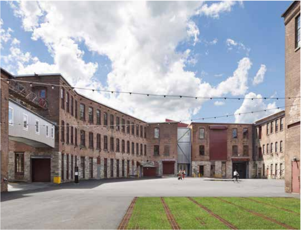
Referensbild: MASS moca building 6, innergård, ombyggnad
