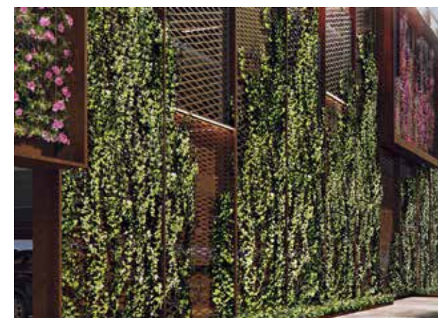
Grön fasad på sträckmetall
