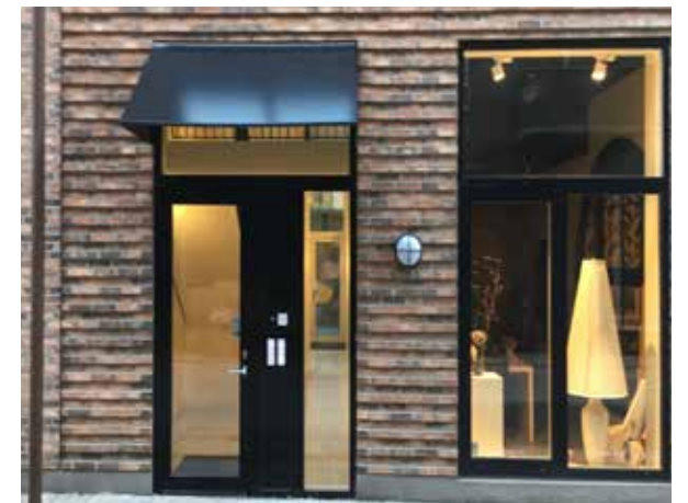
Svartmålad stål i entréparti och skärmtak
