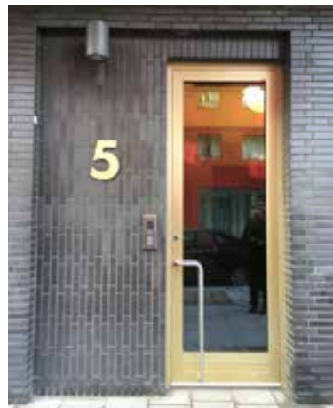
Recess i tegelfasad
