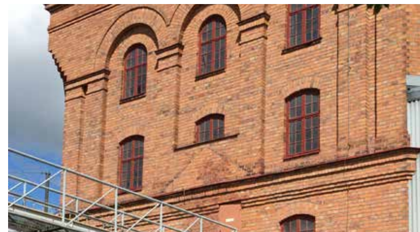
Foto: Västra gaveln, Tegelsilon
