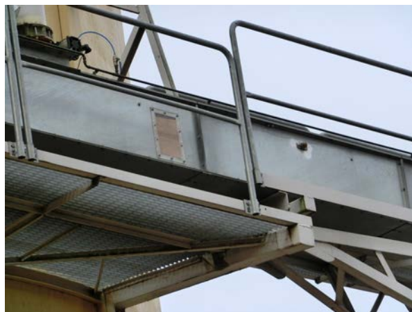
Transportör från spannmålsmottagningen till kvarnanläggningen under pågående spannmålstransport.
