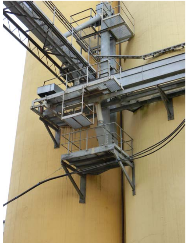
Ovan: Lanterninen på silo 3 med transportör och fördelare mellan de olika lagringsfickorna.
