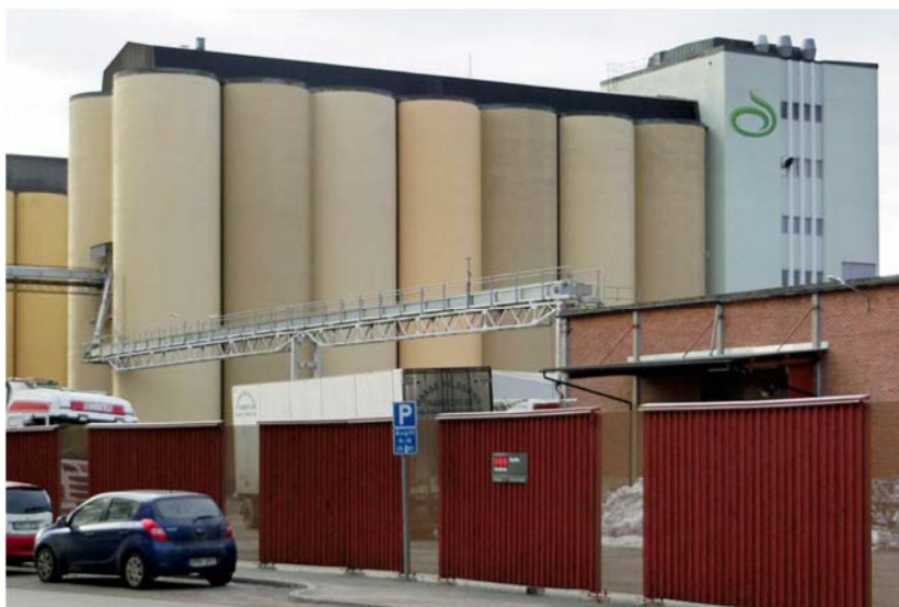
Silobyggnader sett från Ångkvarnsgatan.
