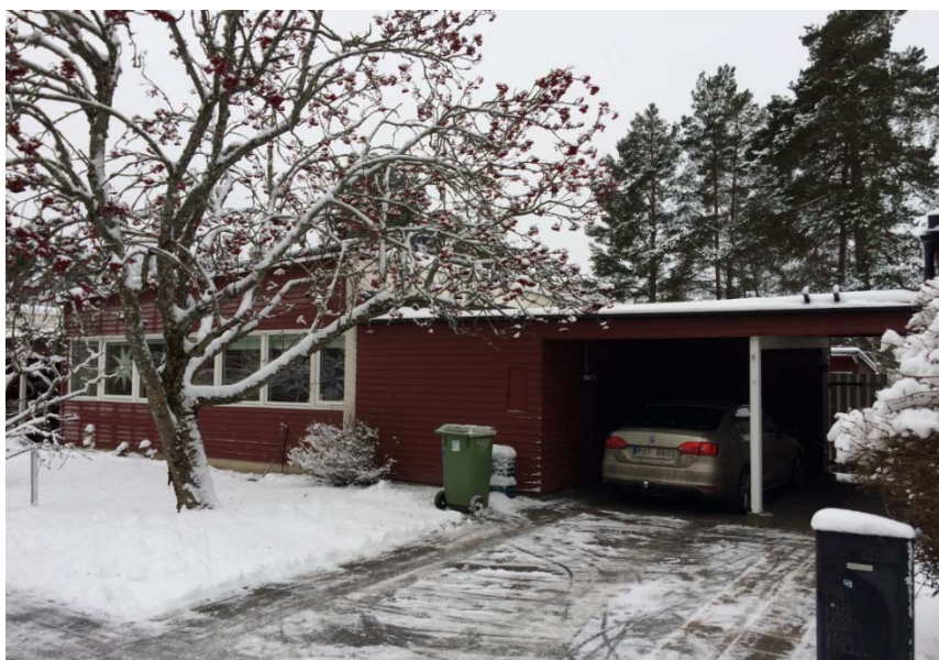
Husen i de båda kvarteren har flacka pulpettak, enhetlig färgsättning och karaktäristiska fönsterband.
