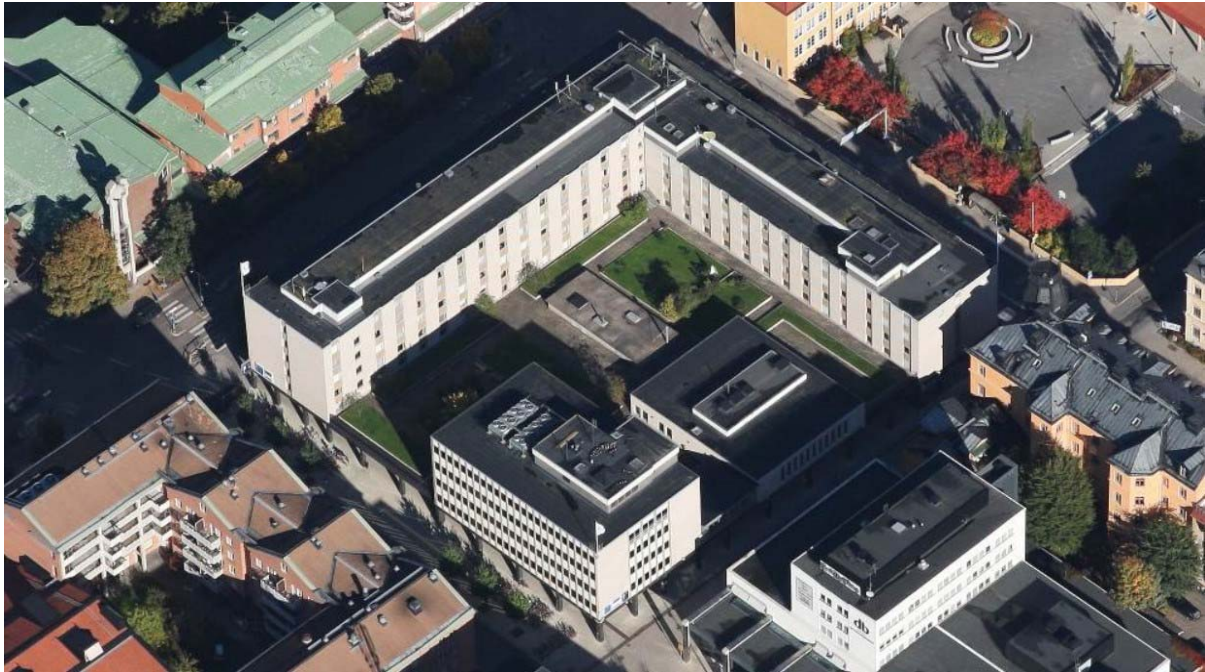
Flygbild över befintlig bebyggelse
