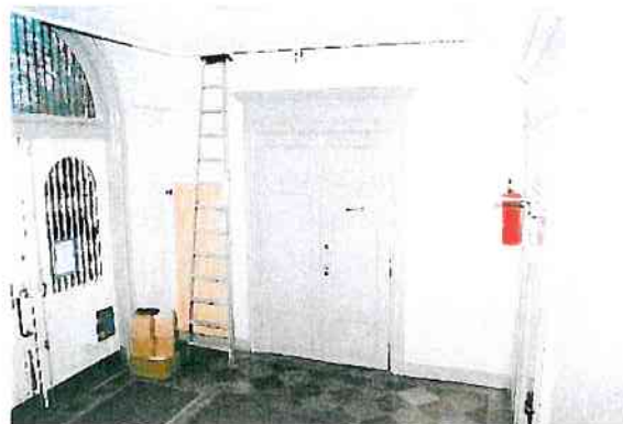
Trapphus i hus 1. Originalsnickerier och kryssvalv dolt bakom akustikplattor
