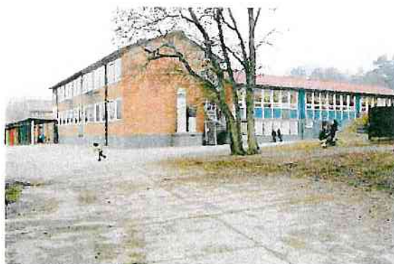
50-talsskolan, hus A, till vänster och hus B-C från 1963 till höger
