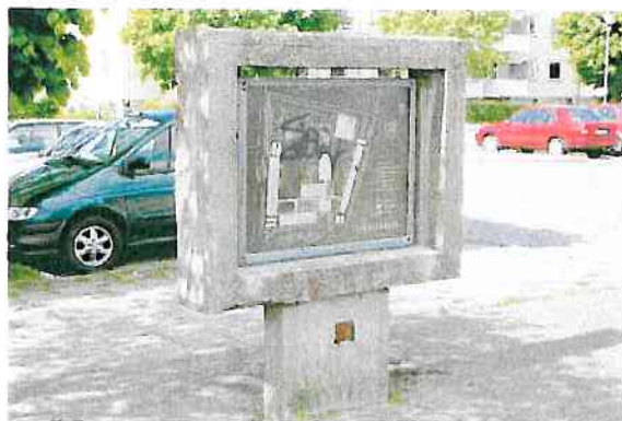
Orienteringstavla med gjuten betongram. En sliten originaldetalj.
