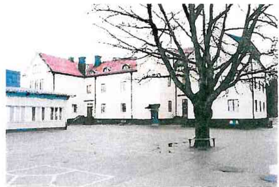
Den gamla skolbyggnaden. Mitt i bild ses den nya utbyggnaden för hiss
