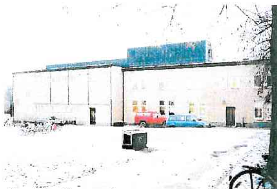
60-talets tillbyggnad mot norr
