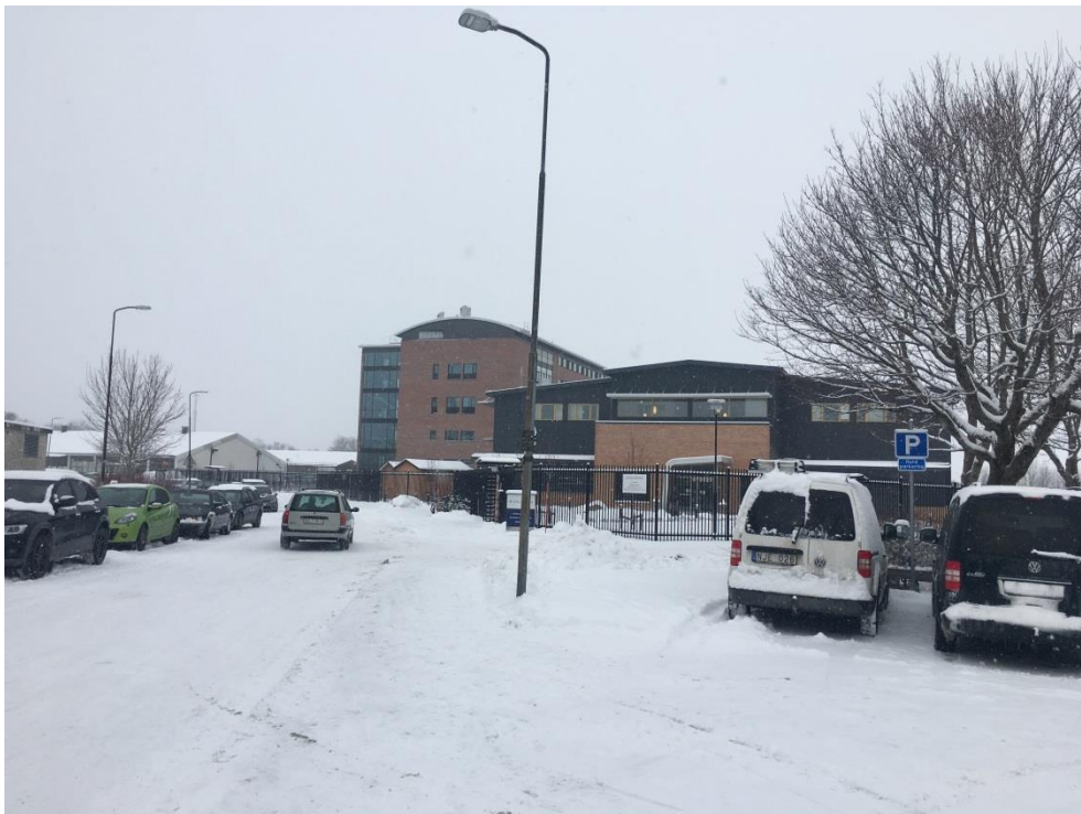
Figur 12 Galdermas lokaler. Byggnad 13 till vänster och byggnad 9 till höger enligt numreringen i översikten i figur 6.
