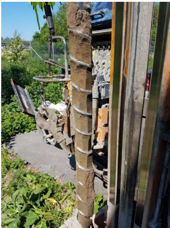
Figur 4. Provpunkt 18BÖR03GV i övergång från fyllnadsjord till lera. Ett grundvattenrör installerades även i denna punkt.
