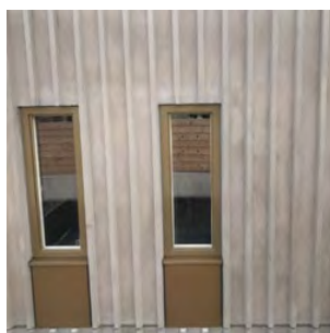
Bearbetning av betong i fasader
