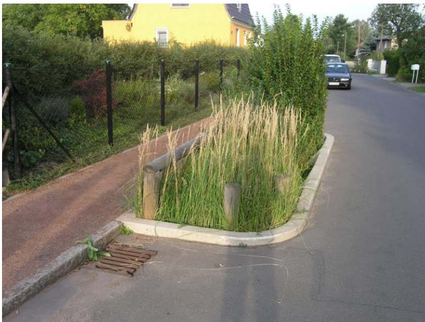
Figur 6. Exempel på nedsänkta växtbäddar vid vägyta. Foto: WRS
