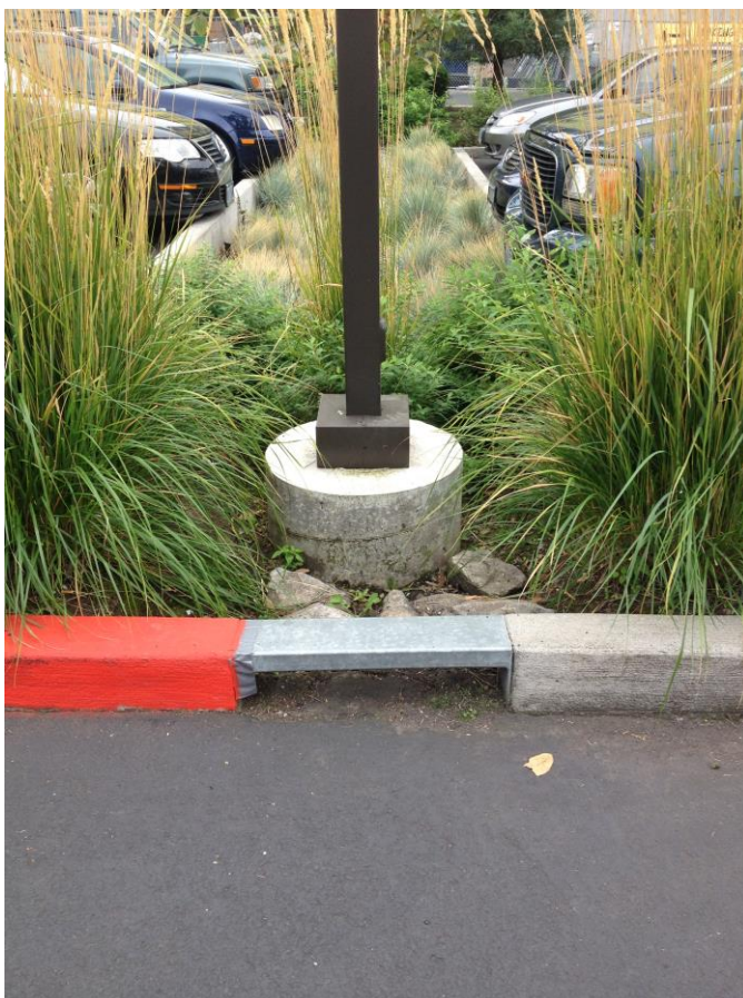
Figur 7. Exempel på inlopp för dagvatten till nedsänkt växtbädd. Foto: WRS.
