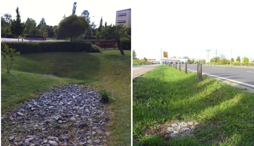
Figur 9. Exempel på enkel utformning av ett enkelt makadamdike (t.v.) resp. infiltrationsstråk (t.h.) som tar emot dagvatten från väg och översilningsyta. Foto: WRS.
