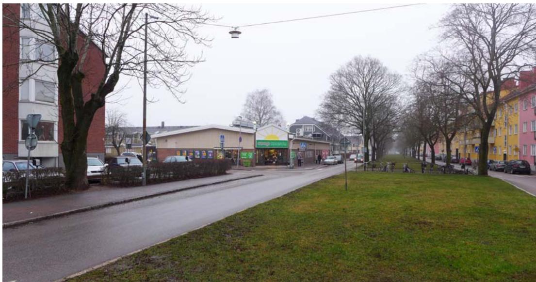
Befintlig bebyggelse består av en livsmedelsbutik i en våning, som täcker en stor del av fastigheten.
