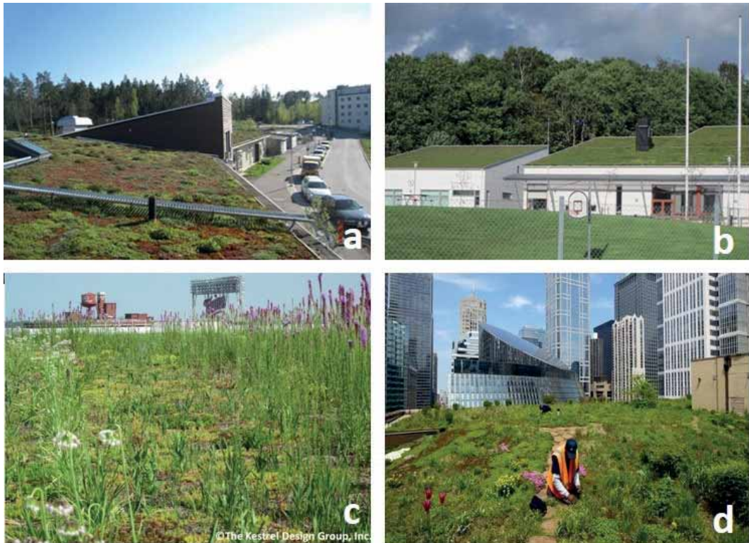
Figur 9. a)-b) Lutande, gröna bostadstak, Sverige (källa: Vegtech.se), c) extensivt sedumtak kompletterat med inhemska växter på Target Centre i Minneapolis, USA (källa: The Kestrel Design Group Inc.), d) stadshuset i Chicago, USA (källa: JoeInSouthernCA Flickr CC BY-ND 2.0).
