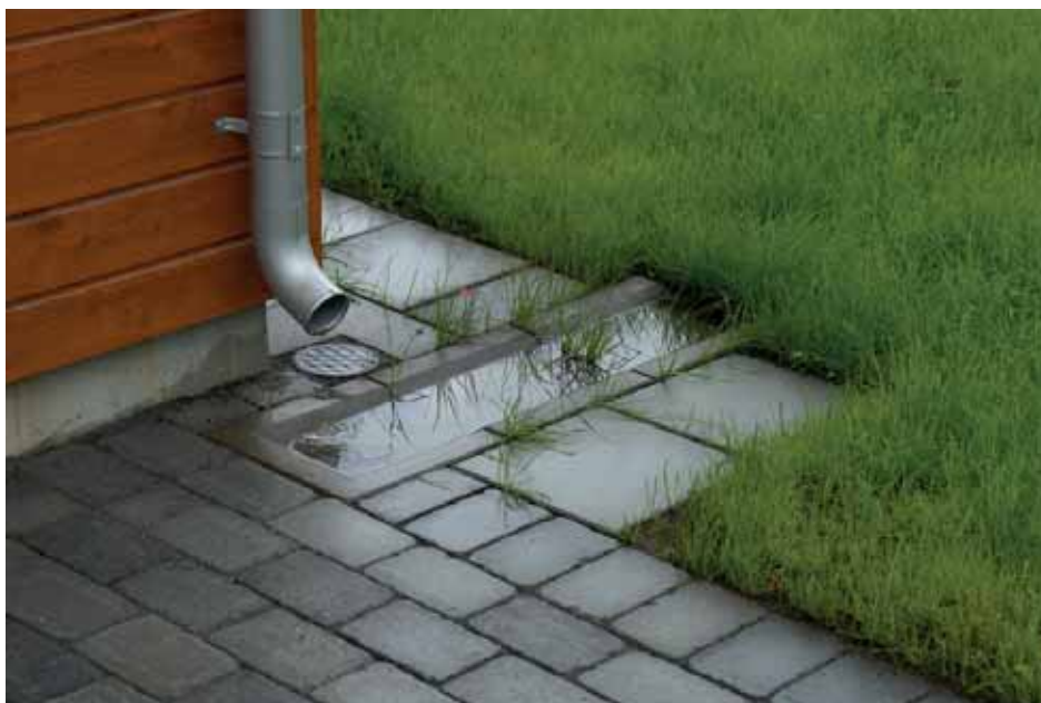
Figur 11. Utkastare som leder ut vatten direkt på gräsytan. (Källa : www.steriks.se ).
