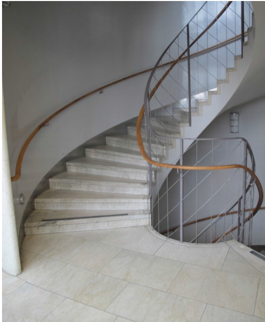
Trapphuset med golv av Ekebergsmarmor.
