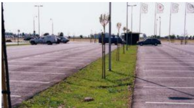
Figur 3-5. TV: Svackdike med nyplanterade träd i Spånga. Källa godaexempel.dagvattenguiden.se, hämtad 2017-04-12. TH: Infiltrationsdike på parkeringen vid Oregon Zoo, Portland. Källa greenworkspc.com, hämtad 2017-04-12.
