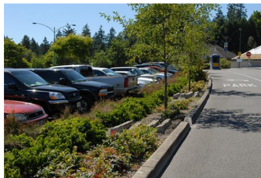
Figur 3-5. TV: Svackdike med nyplanterade träd i Spånga. Källa godaexempel.dagvattenguiden.se, hämtad 2017-04-12. TH: Infiltrationsdike på parkeringen vid Oregon Zoo, Portland. Källa greenworkspc.com, hämtad 2017-04-12.
