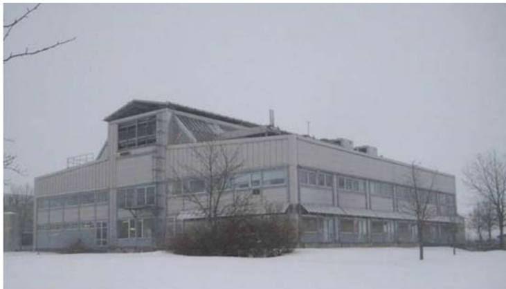
Gaveln på hus 40. Fasader av rostfri plåt. Panel och ramverk av trä. Sadeltak över mittskeppet har tillkommit senare för att skydda installationer. Bild: Kulturmiljöutredning, WSP
