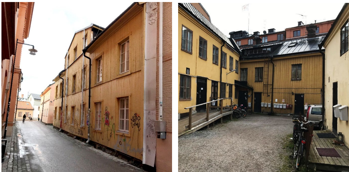
Hus C med bostäder. Till vänster, från Östra Ågatan; till höger, från gården.
