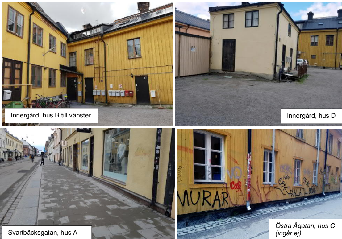
Figur 3. Fastigheten Dragarbrunn 6:2, fotograferad 2018-05-02. Foto: Tyréns AB.
