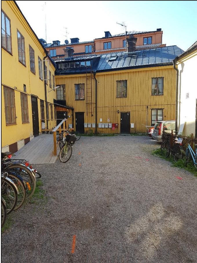
Figur 2. Leopardens innergård, Hus B till vänster, Hus C rakt fram. Källa: Tyréns AB.
