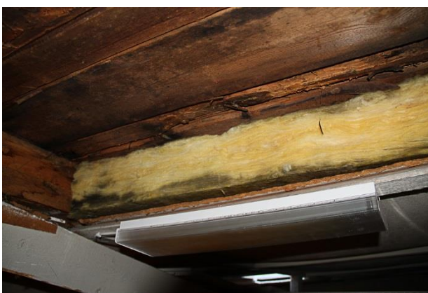
Bild 14. Innertak tilläggsisolerat utan luftspalt.
