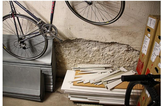
Bild 11. Källarmur med vittrande betong. Grov ballast i form av åsmaterial i betongen. .
