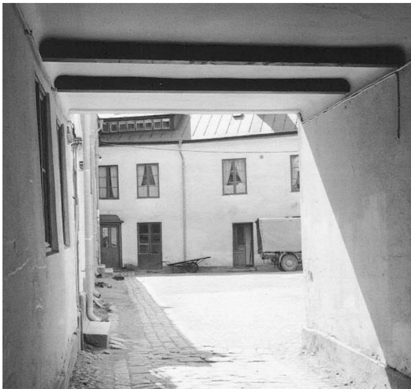
Gårdsinteriör på 1970-talet. Hus 3 i fonden.
