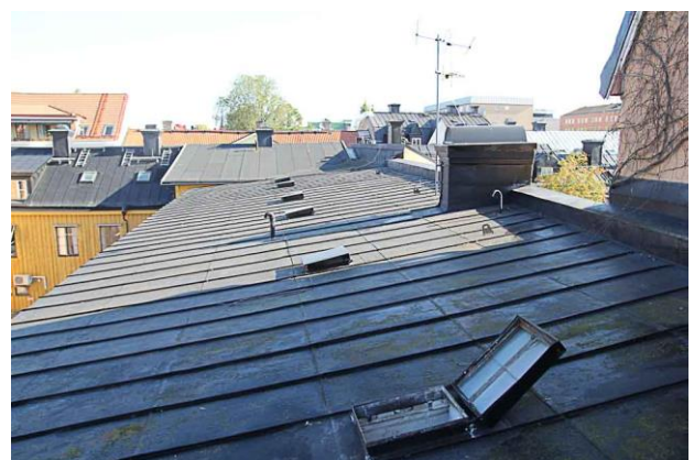
Bild 15. Gammal skivtäckning av plåt på taket.
