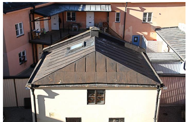
Bild 27. Hus 4 har en gammal skivtäckning av plåt från 1920-talet. Takfönstret är senare tillkommet.
