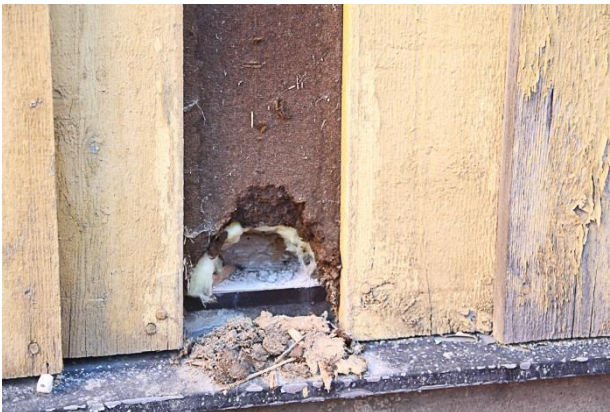
Bild 3. Under fasadpanel ses asfaboard och bakom den en mineralullsskiva mot timmerstommen.
