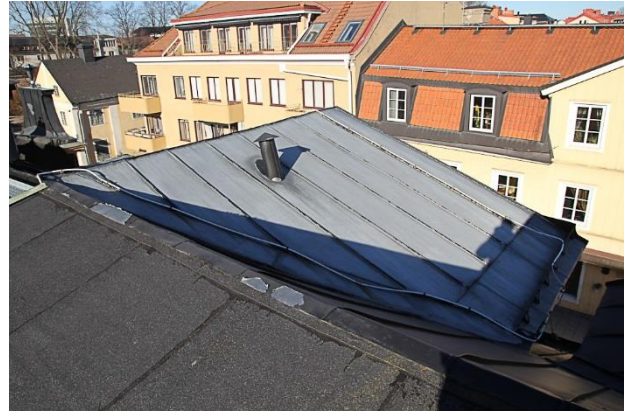
Bild 8. Plåttaket med flagnande färg.
