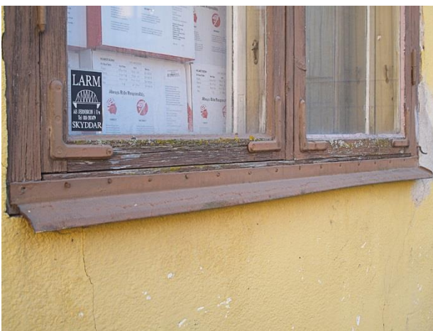
Bild 20. Fönstersnickerier, algpåväxt på bottenstycke, rötskador.
