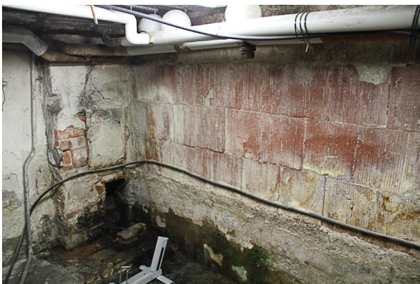
Bild 12. Insida källarmur i f.d. pannrum. Fuktigt golv.
