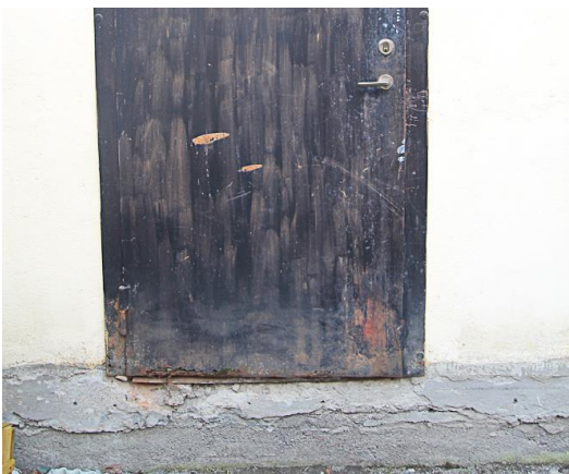
Bild 26. Rosthål i nedkant av ståldörr.
