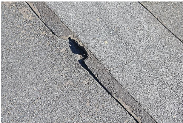
Bild 9. Trasig skarv på papptaket.
