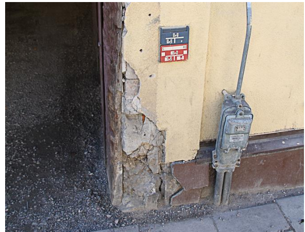
Bild 4. Skador i puts vid infarten till gården från Svartbäcksgatan.
