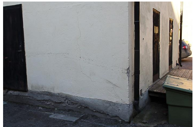
Bild 25. Skadad sockelputs, sönderfruset stuprör.
