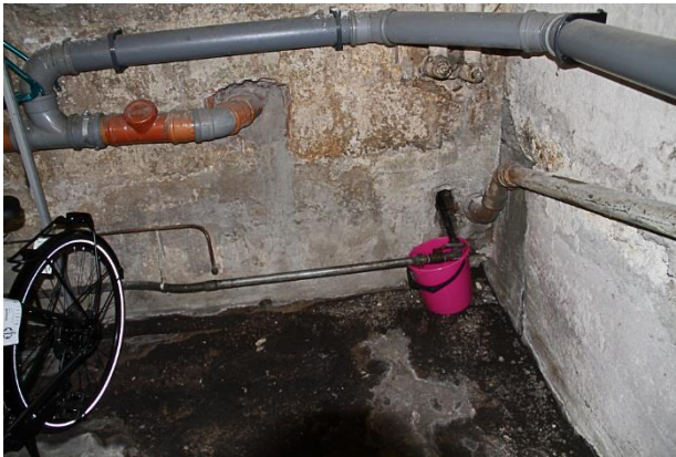
Bild 10. Fuktigt golv i källaren.
