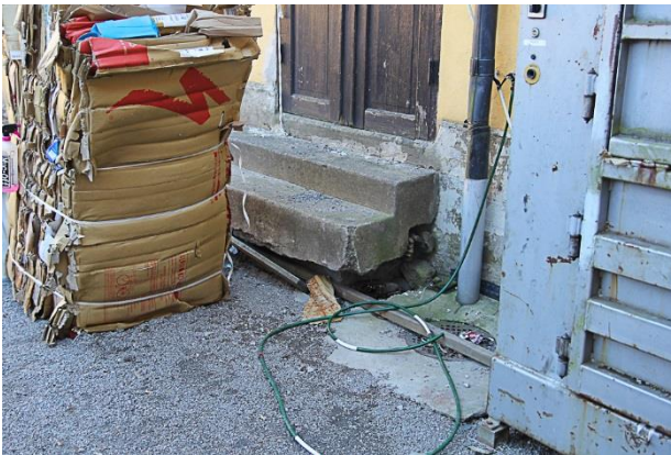
Bild 18. Marken har sjunkit närmast betongtrappan. Skadad stuprörsanslutning vid markrör av plast.
