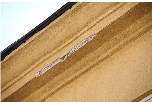
Bild 5. Sprickor i fasadputs under takfotslist.
