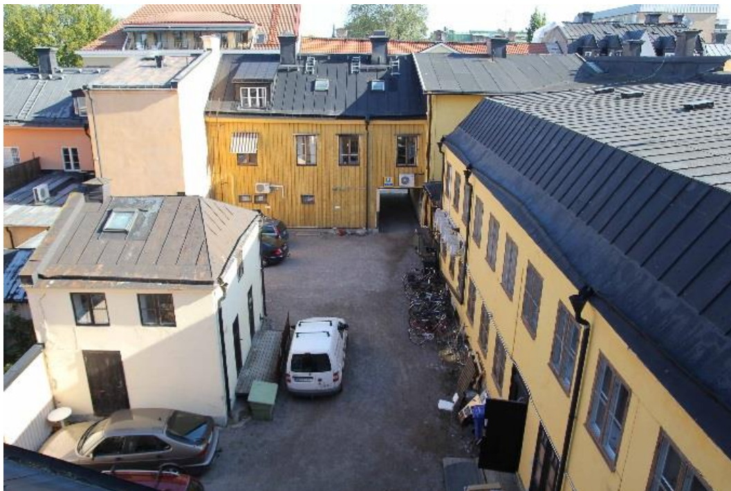
Gårdsbild med hus 1 i fonden. Hus 2 t.h.
