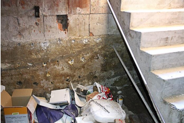
Bild 22. Källartrappa. Källarmuren är försedd med ett slags håltegelplattor på insidan från ca 70 cm över golv och uppåt. Detsamma gäller för källaren i hus 2.
