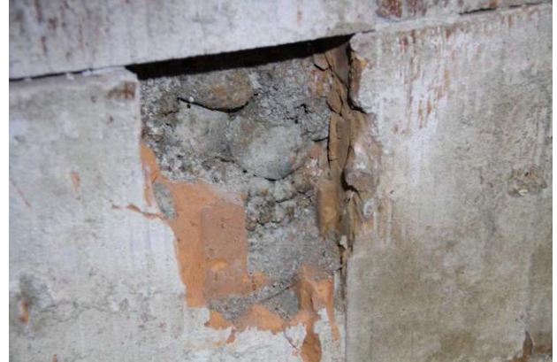
Bild 23. Närbild av håltegel och betong med åsmaterial som ballast.
