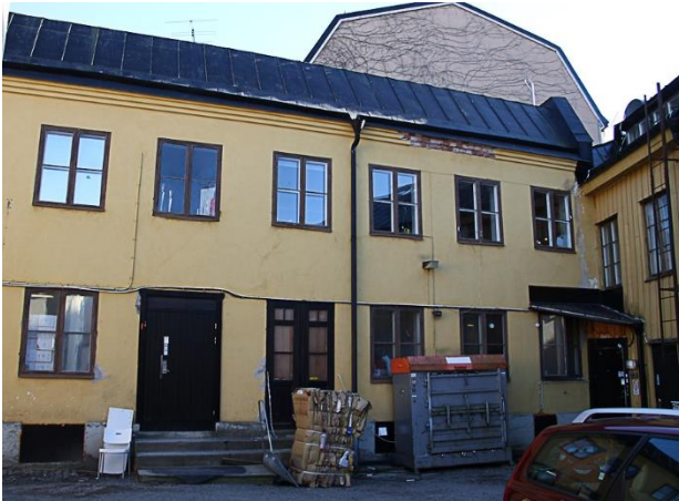
Bild 16. Fasad mot gård. Putsskadad takfot.
