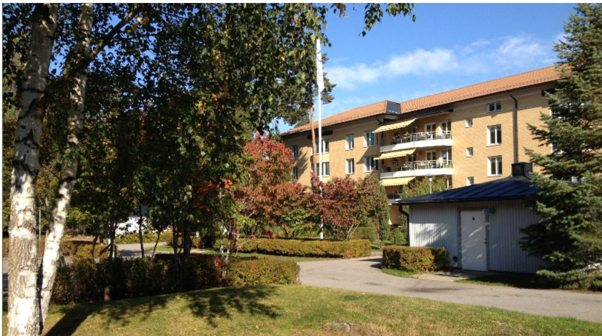
Planområdet sett från Västgötareisan in mot gården mot norr. Den gula tegelbyggnaden är vårdboendet inom fastigheten.
