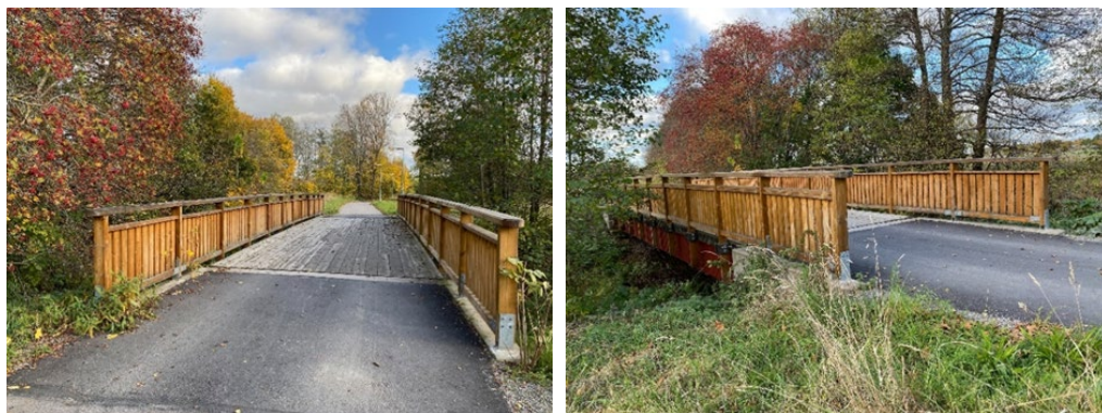
Bild 19 Exempel på en låg gång-och cykelbro i trä utan stödben. Bron ligger längs med Fyrisån öster om Librobäck.
