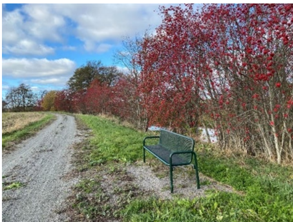
Bild 17 Exempel på utformning av gång- och cykelväg. Bilden visar gång- och cykelvägen mellan Ulva och väg 600 som är grusad med sittbänkar längs vägen.
