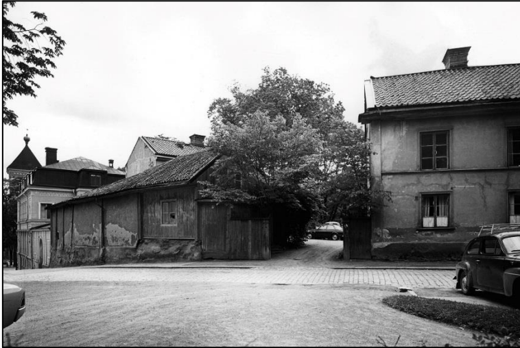
Vy längs Åsgränd före rivningarna på 1960-talet. Från vänster syns Helga Trefaldighetskyrkan, f.d. Lindska skolan och ekonomibyggnader längs gatan med stenhusets gavel stickandes upp ovanför. Till höger rådman Alms hus. Foto: Okänd. Ur rivningsdokumentationen i Uppsala stadsarkiv.
