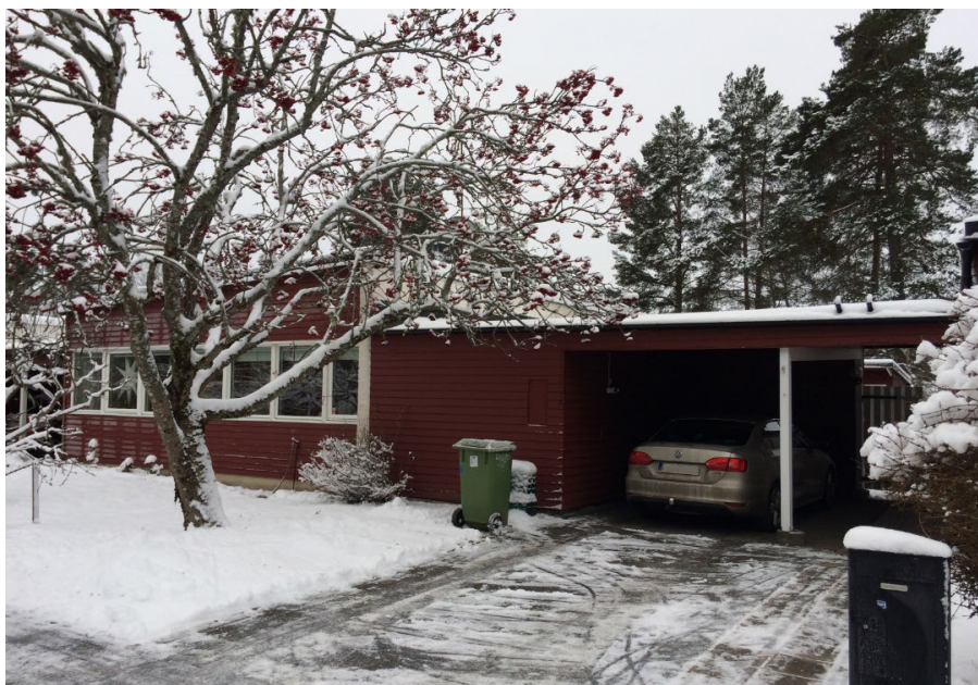
Husen i de båda kvarteren har slacka pulpettak, enhetlig färgsättning och karaktäristiska fönsterband.
