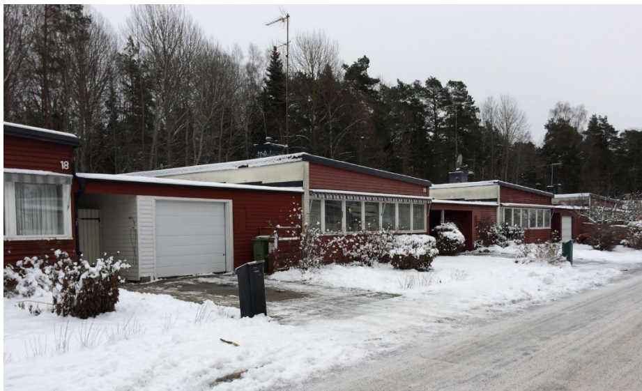
Kvarteret Skogschampinjonen sedd från gatusidan. Det sammanhållna 60-talsuttrycket är väl bevarat, även om en del carports har byggts om till garage. Mellan garage/carport och bostadsdel syns passagen in till atriumgården.
