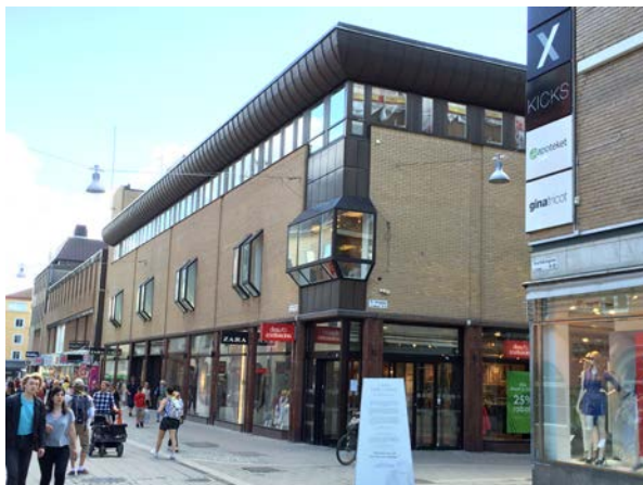
Byggnaden sedd från Svartbäcksgatan
