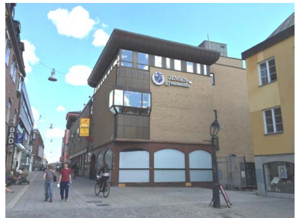
Byggnaden sedd från Gamla torget
