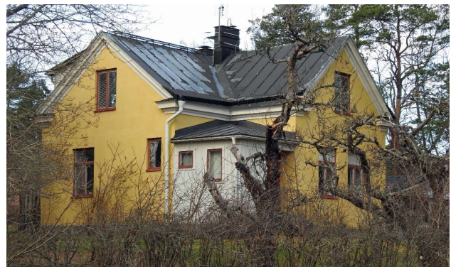
Fastighet 11:12, fasad mot öster.
