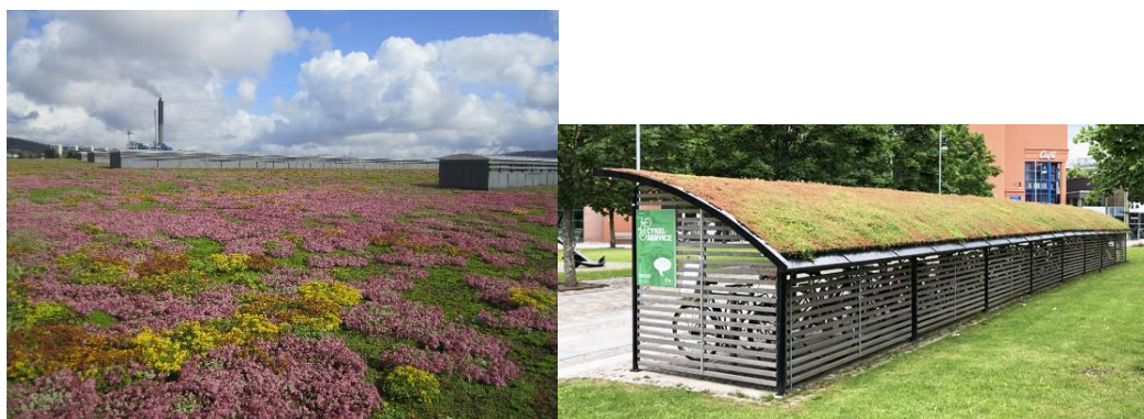
Figur 18. Fotot till vänster: 27 000 m 2 sedumtak på en återvinningsanläggning utanför Oslo. Fotot till höger: Sedumtak på cykelparkering i Lindholmen i Göteborg. Foton: Veg Tech AB.
