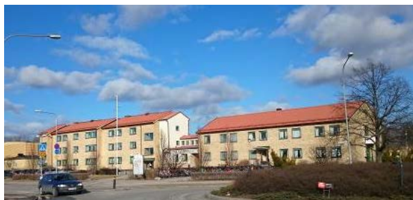
Bolandsskolan från Bergsbrunnagatan
