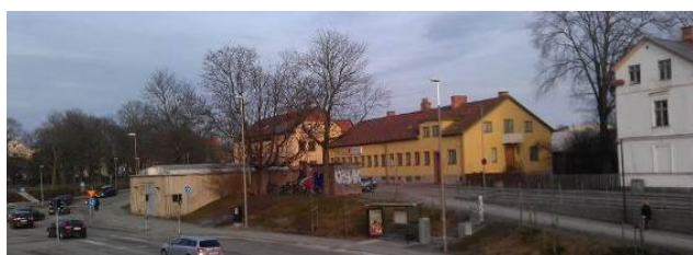
Aliskegatan sedd från tomten där "Juvelen" byggs. De tekniska anläggningarna dominerar mot Strandbodgatan.
