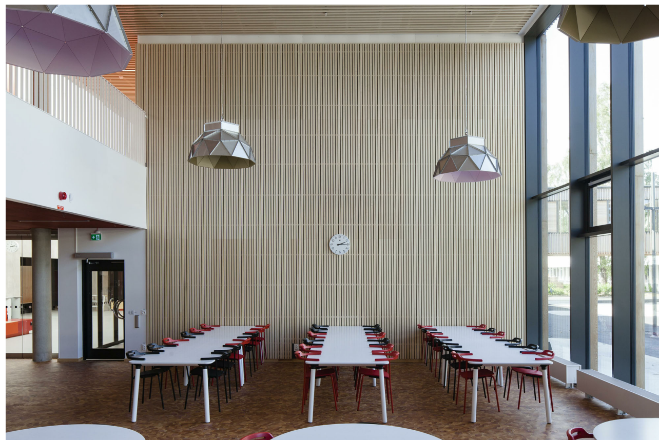
Fredrika Bremersgymnasiet, Cedervall arkitekter. Matsal, akustikpanel, kubbgol
