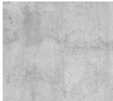
Vägg Råbetong bärande väggar i trapphus
