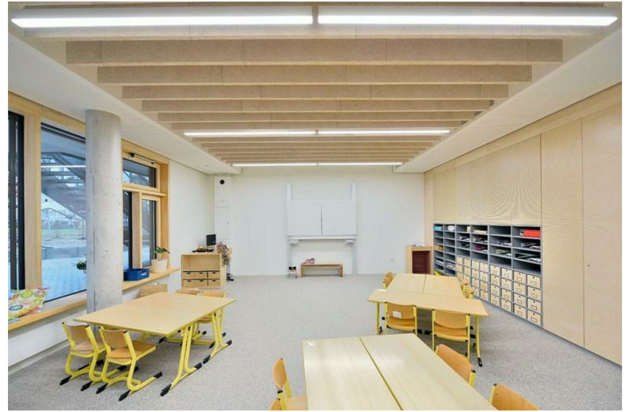
Ludeig Weber shule, klassrum. Akustikabsorbenter i tak, Troldekt, träfönster på insidan.
