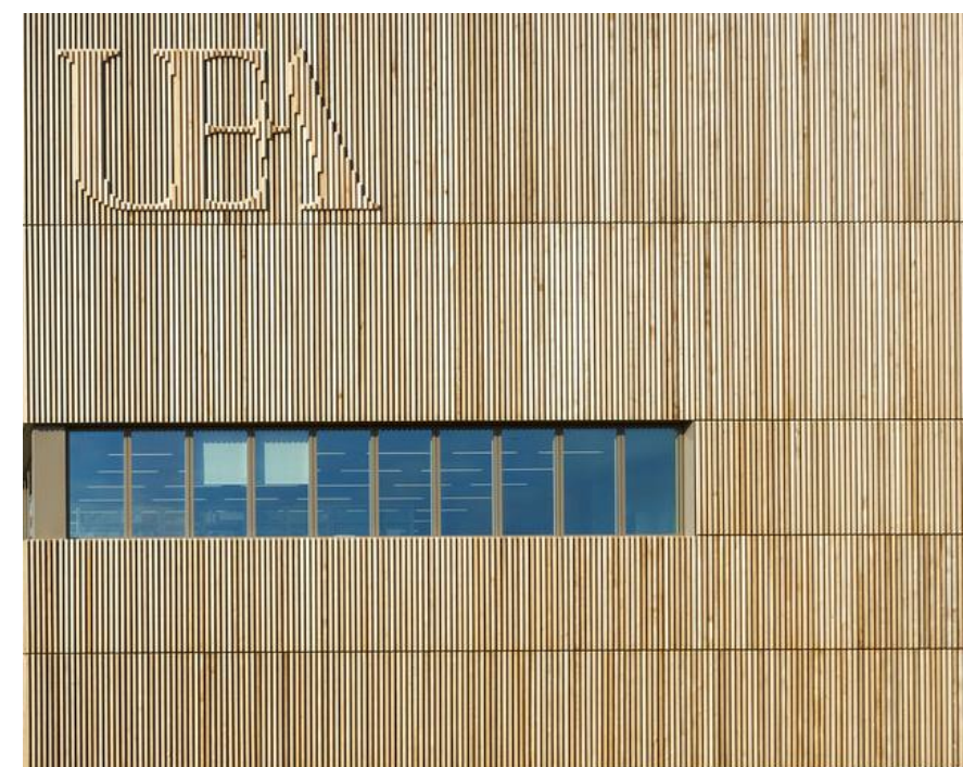
Idrottshall får bärande konstruktioner av limträ och träfasad. Utrymningstrappa skärmas av ribbpanel av trä och bildar samtidigt solavskärmning för arbetsrum i bottenvåning.
