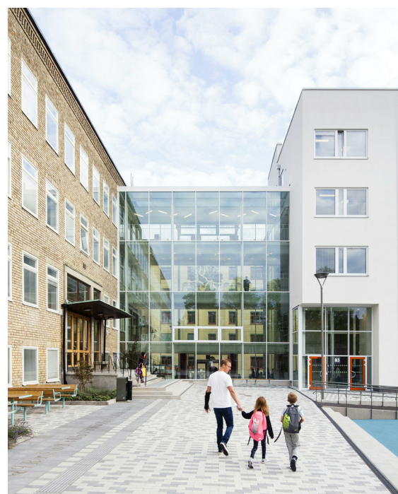
Fönster med kopplade bågar och mellanglaspersienner, Glaslänk med självdragsventilation. Kungsholmensgrundskolan, Cedervall arkitekter
