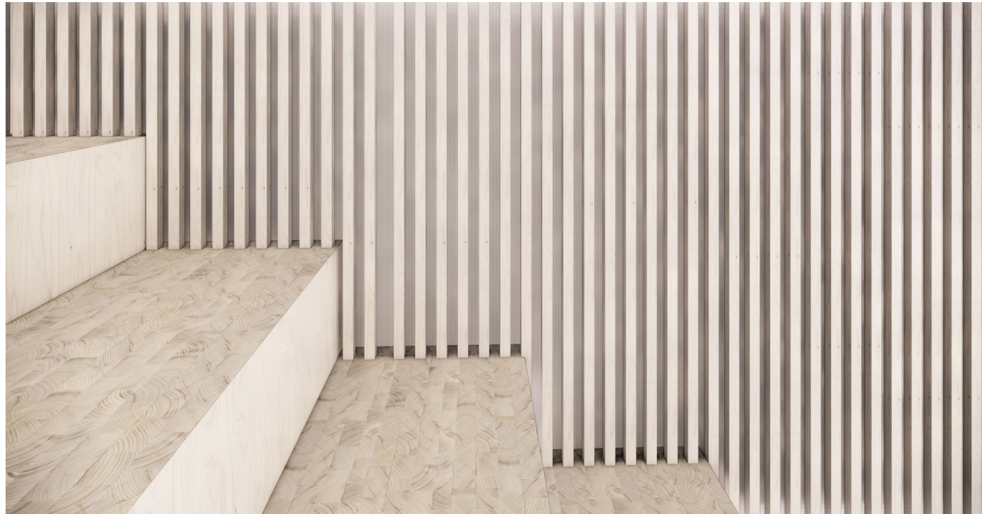
Detalj. Sittgradäng i matsal av furukubb behandlad med hårdvaxolja med vitpigment. Kubbens struktur är en naturlig ljudabsorbent. Väggbeklädnad av akustikpanel med ljudabsorberande material bakom.
