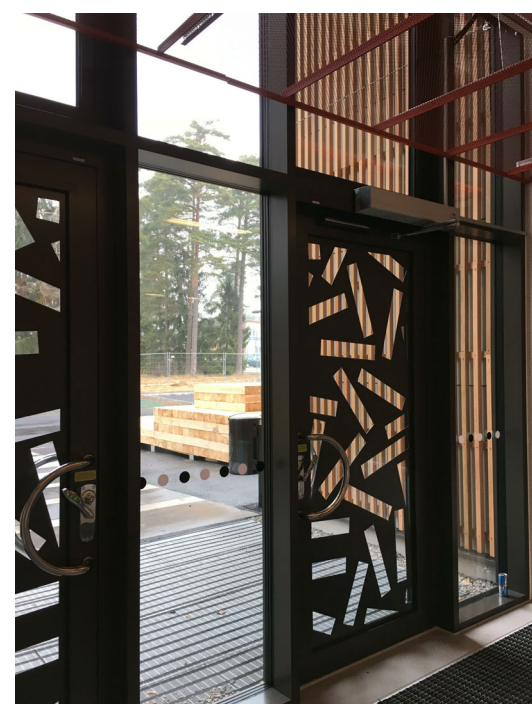
Entrépartier av stål, pulverlackerade. Fredrik Bremersgymnasiet. Cedervall arkitekter
