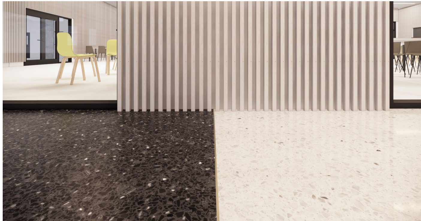
Detalj. Platsgjuten terrazzo i mönster som visuellt förstärker olika stråk och underlättar orientering även för synsvaga tack vare kontrast och ingjuten text (alternativ skyltning). Akustikpanel av träribbor med ljudabsorberande material bakom bidrar till en bra ljudmiljö i hallen.
