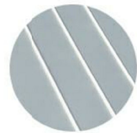
tak av stålplåt
