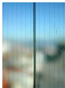
Vägg / gruppum Isberget Profilt Pilkintonglas
