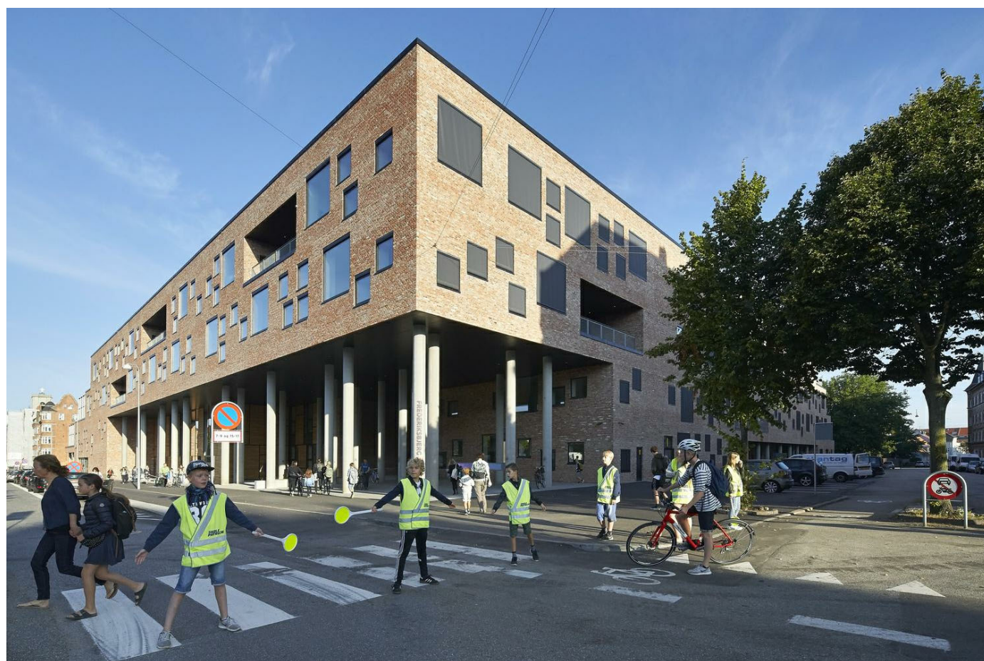
Frederiksbjerg skole, Århus. Huvudentré, elevtorg
